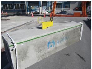
地切りした時に、水平度を確認してください 水平度が悪ければ、一旦降して、**吊り具先端の** 位置を微調整してください
