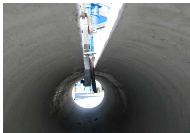
⑤ 吊り上げ時の管内状況です。
