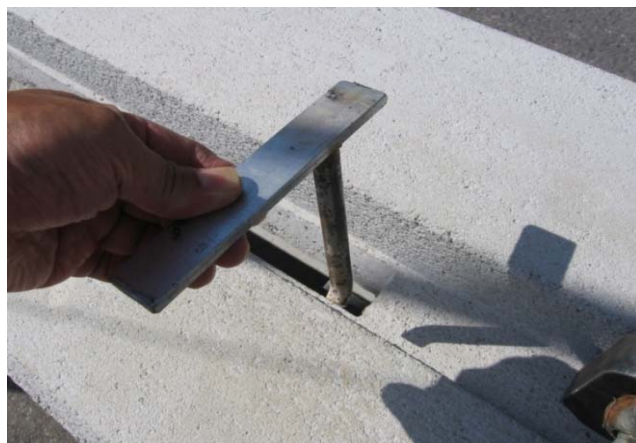
③ バランス調整ピンを写真のようにセットします。
